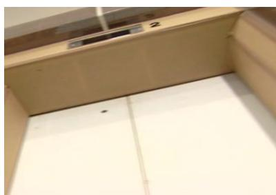
4. 交樓前，升降機已需投入操作，所以保護裝置不能妨礙操作，包括按鈕、照明設備、通風設備、閉路電視系統及逃生門
