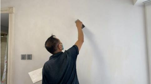
3. 檢查牆面是否有空洞開裂，可輕輕敲擊牆面，若發出實心砰砰聲時，則牆面完好
