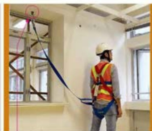
圖 7 - 工人使用有眼螺栓時的情況
